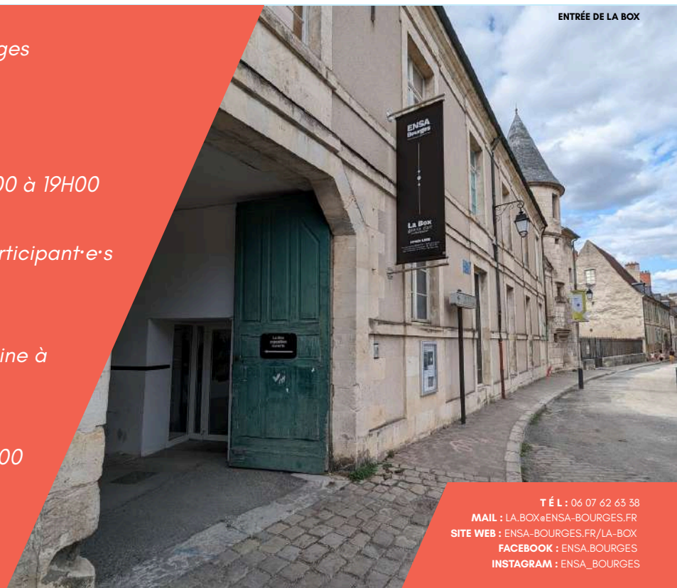
ENTRÉE DE LA BOX
